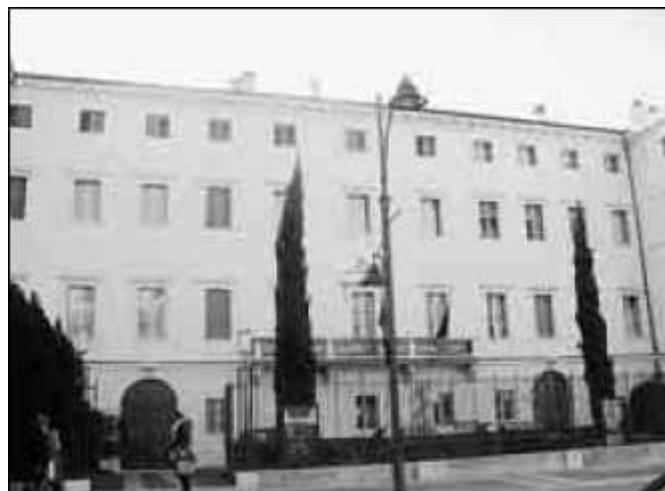
Il palo che tagli la visione della facciata (foto CP)
